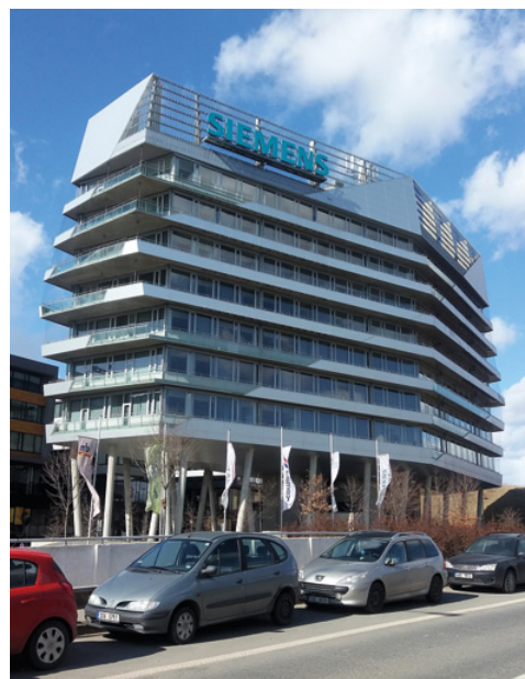
Tam, kde dnes stojí administrativní budova Siemens, mělo stát záchranné parkoviště P+R pro 400 automobilů, a tak jeho zaměstnanci parkují v odstavných pružích.
