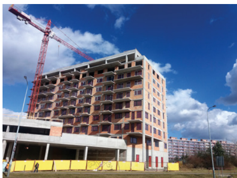
Aktuální probíhající výstavba při ulici Jeremiášova.
