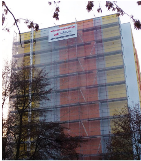
Objekt Společenství vlastníků Daškova 3078–3081, Praha 4, kde právě probíhá zateplování.
