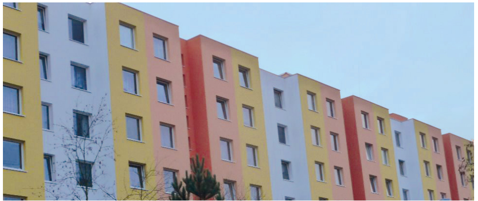
Takhle vypadá objekt po provedeném zateplení.
