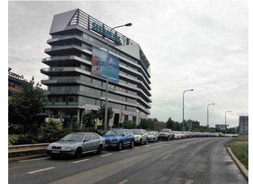
Na místě, kde mělo být záchytné parkoviště, stojí budova Siemens, a tak řidiči parkují svá vozidla v odstavných pruzích.
