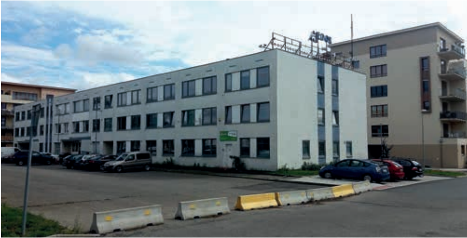
Kancelářská budova Medox.
