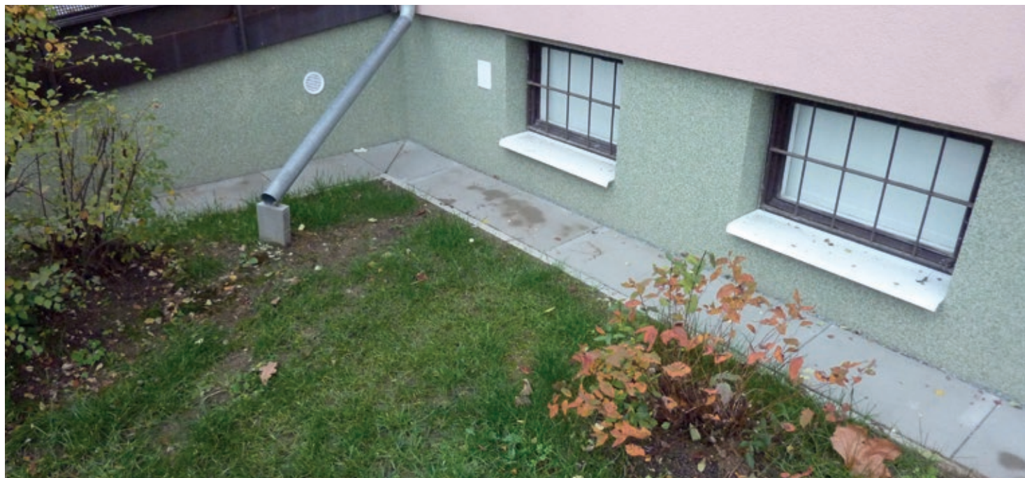
Obr. 2. Objekt Nechvílova 1820-1822 snížil energetickou náročnost také zateplením soku objektu.
