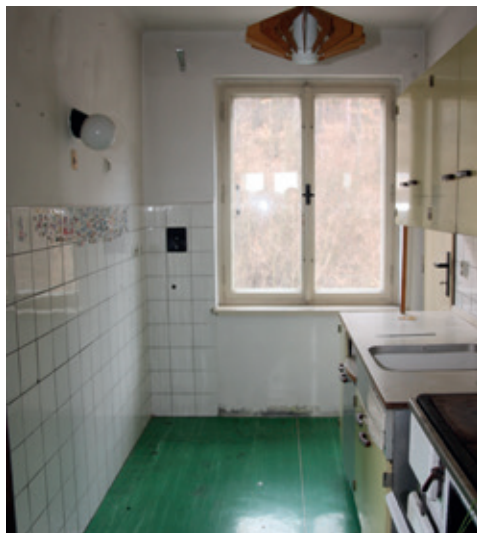
Původní stav před rekonstrukcí kuchyně ve starším bytě.
