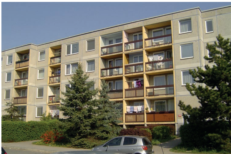
Objekt v ulici Vokrojova 3342 v Praze 4 před zateplením...
