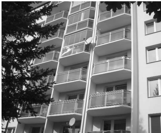
Panelové domy v Holešově, které spravuje SBD Novosad, působí po rekonstrukci opravdu elegantně.
